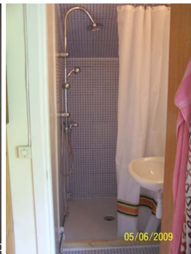
23/06/2007 In jedem Stockwerk ist ein Duschbad und WC
